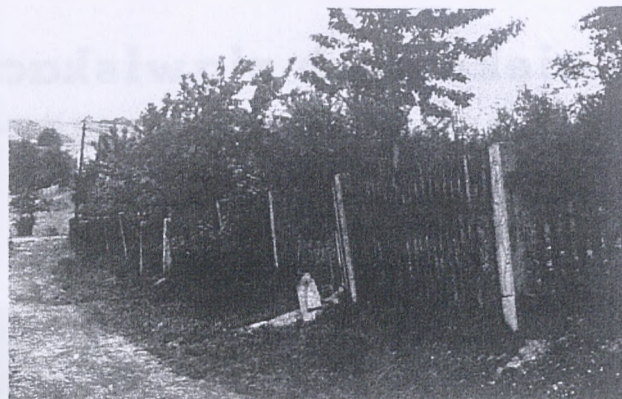
Ryc. 4. Wychylenie się z pionu słupków ogrodzenia domu p. Wójcika w Pszowie wskutek zsuwów powierzchni gruntu.
