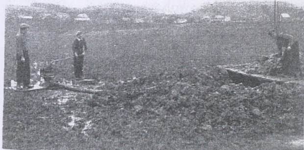
Ryc. 10. Budowa przewodu napowietrznego 20 kV na słupach drewnianych do mleczarni w Belsznicy.
