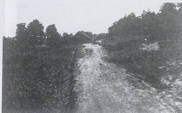
Ryc. 2. Droga polna Kopalnia »Anna«—Krzyżkowice powyginana wskutek zsuwania się powierzchni zbocza.
