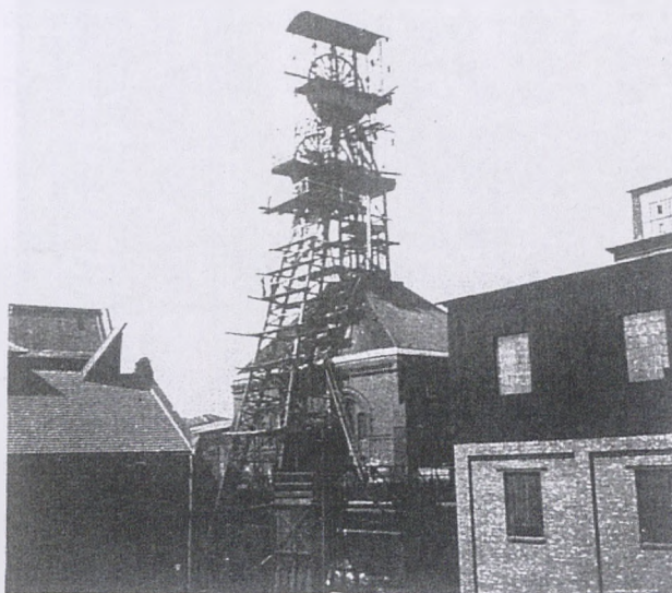
Wieża szybu »Antoni« podczas wzmacniania przed zawieszeniem skipów.
