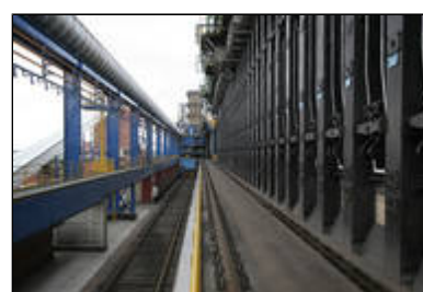
Bateria Koksownicza wraz z instalacją odpylania Koksownia Radlin
