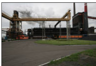
Bateria Koksownicza-Koksownia Jadwiga
