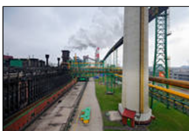
Bateria Koksownicza-Koksownia Przyja
