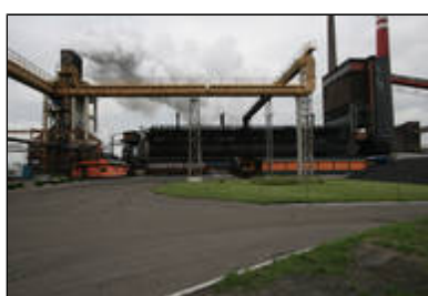
Bateria Koksownicza-Koksownia Jadwiga
